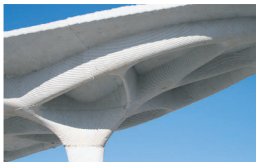
Her kan robotens fræsespor ses i en færdig betonpavillon.
